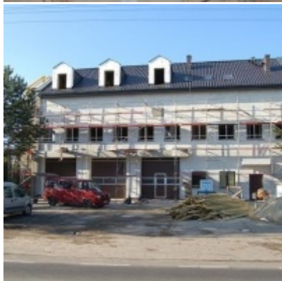
Przebudowa i modernizacja remizy strażackiej w Zatorze
