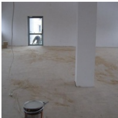
Przebudowa i modernizacja remizy strażackiej w Zatorze
