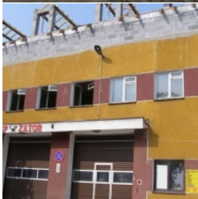
Przebudowa i modernizacja remizy strażackiej w Zatorze
