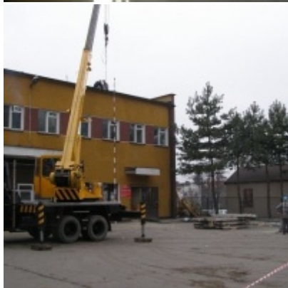
Przebudowa i modernizacja remizy strażackiej w Zatorze
