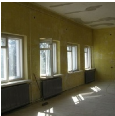
Przebudowa i modernizacja remizy strażackiej w Zatorze
