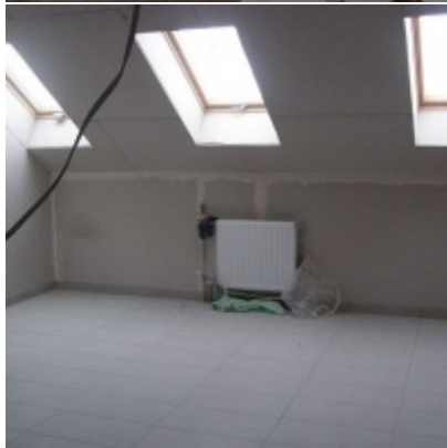
Przebudowa i modernizacja remizy strażackiej w Zatorze
