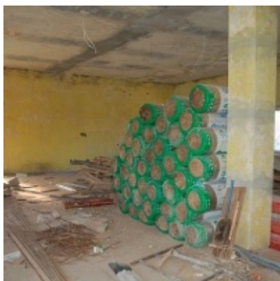
Przebudowa i modernizacja remizy strażackiej w Zatorze
