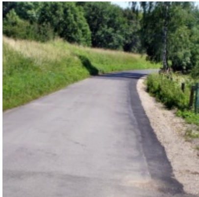
Inwestycje drogowe realizowane w 2009 r. - Wałowa
