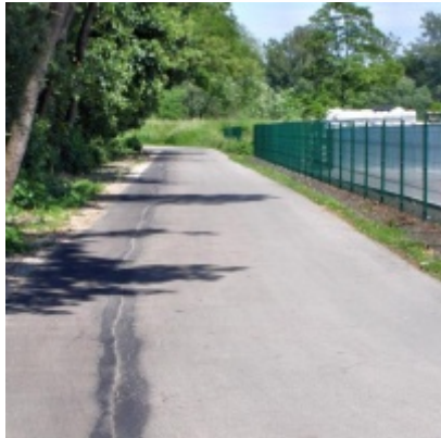
Inwestycje drogowe realizowane w 2009 r. - Wałowa
