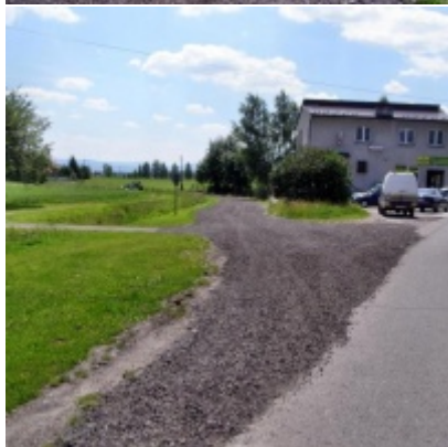
Inwestycje drogowe realizowane w 2009 r. - Stawowa
