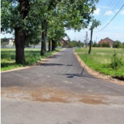
Inwestycje drogowe realizowane w 2009 r. - Droga w Smolicach
