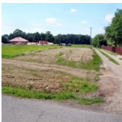
Inwestycje drogowe realizowane w 2009 r. - Brzezina
