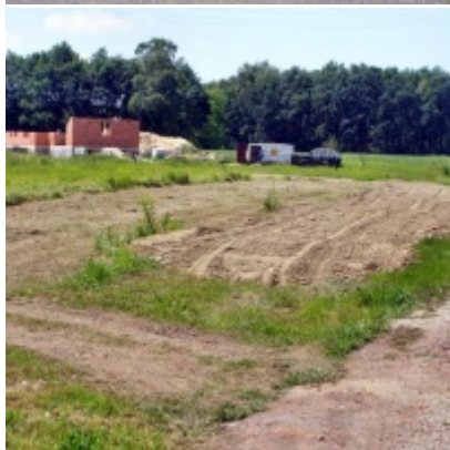
Inwestycje drogowe realizowane w 2009 r. - Brzezina
