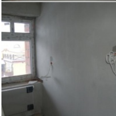
Rozbudowa i remont budynków Urzędu Miejskiego 2008/2010
