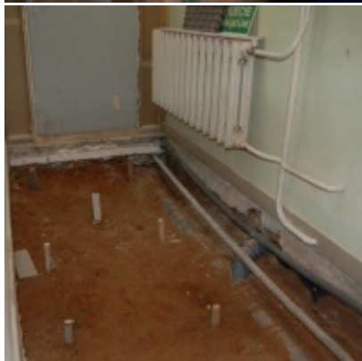
Rozbudowa i remont budynków Urzędu Miejskiego 2008/2010
