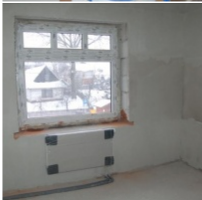
Rozbudowa i remont budynków Urzędu Miejskiego 2008/2010
