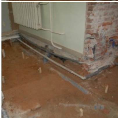
Rozbudowa i remont budynków Urzędu Miejskiego 2008/2010
