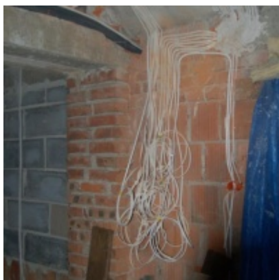
Rozbudowa i remont budynków Urzędu Miejskiego 2008/2010
