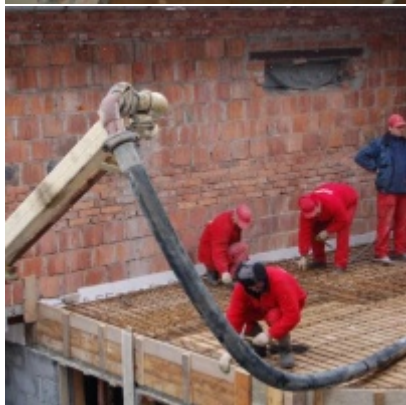
Rozbudowa i remont budynków Urzędu Miejskiego 2008/2010
