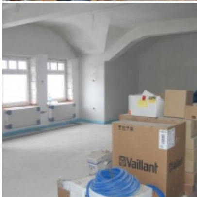
Rozbudowa i remont budynków Urzędu Miejskiego 2008/2010
