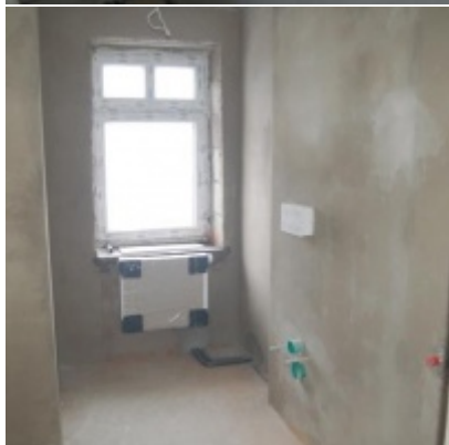
Rozbudowa i remont budynków Urzędu Miejskiego 2008/2010
