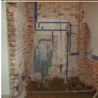
Rozbudowa i remont budynków Urzędu Miejskiego 2008/2010
