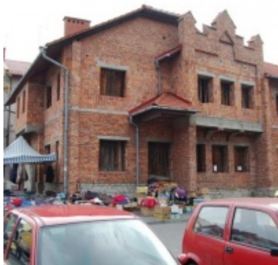
Rozbudowa i remont budynków Urzędu Miejskiego 2008/2010
