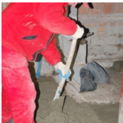
Rozbudowa i remont budynków Urzędu Miejskiego 2008/2010
