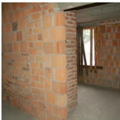
Rozbudowa i remont budynków Urzędu Miejskiego 2008/2010
