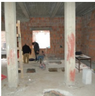
Rozbudowa i remont budynków Urzędu Miejskiego 2008/2010
