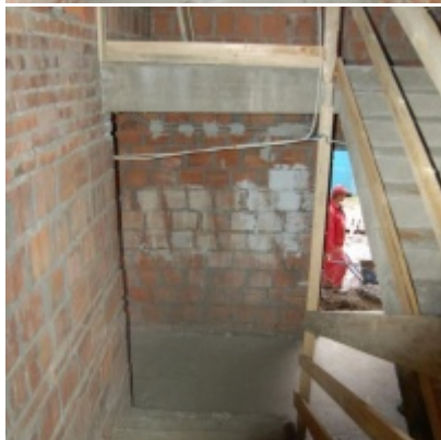
Rozbudowa i remont budynków Urzędu Miejskiego 2008/2010
