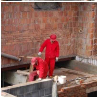
Rozbudowa i remont budynków Urzędu Miejskiego 2008/2010
