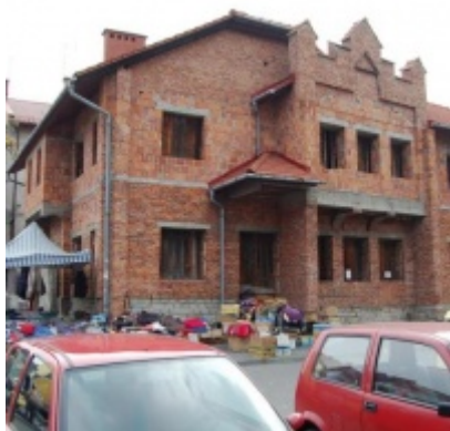
Rozbudowa i remont budynków Urzędu Miejskiego 2008/2010
