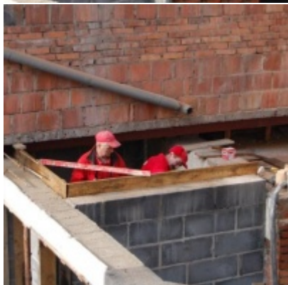
Rozbudowa i remont budynków Urzędu Miejskiego 2008/2010
