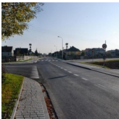
Kompleksowa modernizacja ciągu komunikacyjnego - ul. J. Słowackiego
