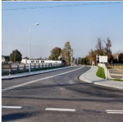
Kompleksowa modernizacja ciągu komunikacyjnego - ul. J. Słowackiego
