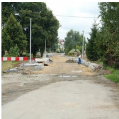
Kompleksowa modernizacja ciągu komunikacyjnego - ul. J. Słowackiego
