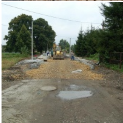
Kompleksowa modernizacja ciągu komunikacyjnego - ul. J. Słowackiego
