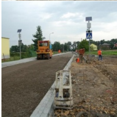
Kompleksowa modernizacja ciągu komunikacyjnego - ul. J. Słowackiego
