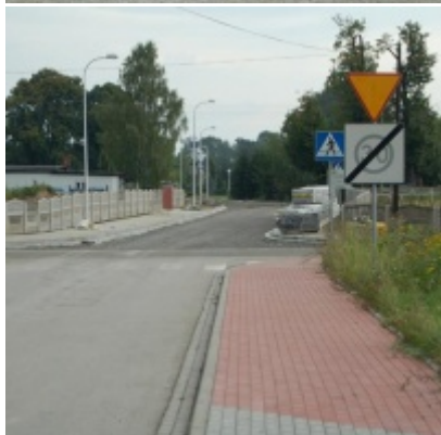
Kompleksowa modernizacja ciągu komunikacyjnego - ul. J. Słowackiego
