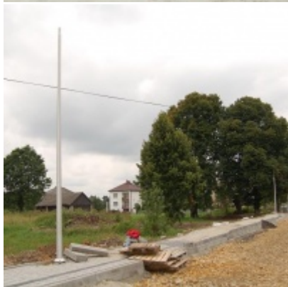
Kompleksowa modernizacja ciągu komunikacyjnego - ul. J. Słowackiego
