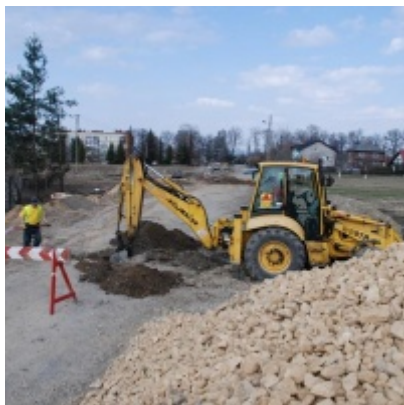
Kompleksowa modernizacja ciągu komunikacyjnego - ul. J. Słowackiego
