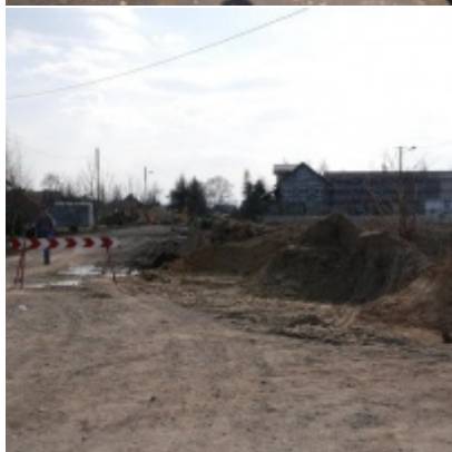
Kompleksowa modernizacja ciągu komunikacyjnego - ul. J. Słowackiego
