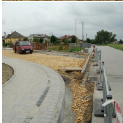
Kompleksowa modernizacja ciągu komunikacyjnego - ul. J. Słowackiego
