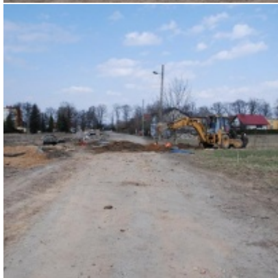
Kompleksowa modernizacja ciągu komunikacyjnego - ul. J. Słowackiego
