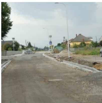
Kompleksowa modernizacja ciągu komunikacyjnego - ul. J. Słowackiego
