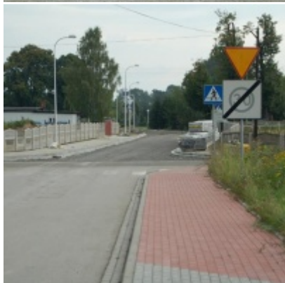
Kompleksowa modernizacja ciągu komunikacyjnego - ul. J. Słowackiego
