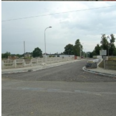
Kompleksowa modernizacja ciągu komunikacyjnego - ul. J. Słowackiego
