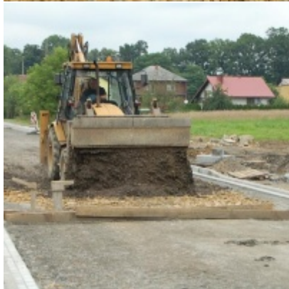
Kompleksowa modernizacja ciągu komunikacyjnego - ul. J. Słowackiego
