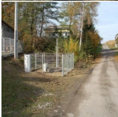
Budowa kolektora i sieci kanalizacyjnej w Graboszycach, Rudzach i Trzebieńczycach
