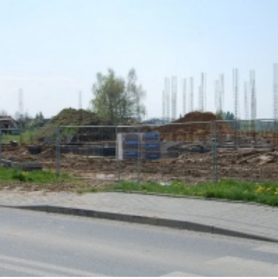
Budowa "Centrum Aktywizacji Zawodowej"
