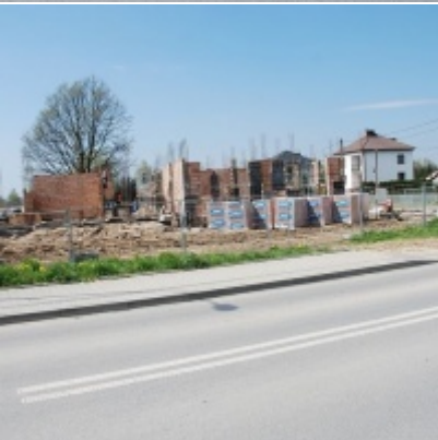
Budowa "Centrum Aktywizacji Zawodowej"
