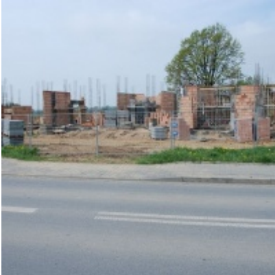
Budowa "Centrum Aktywizacji Zawodowej"
