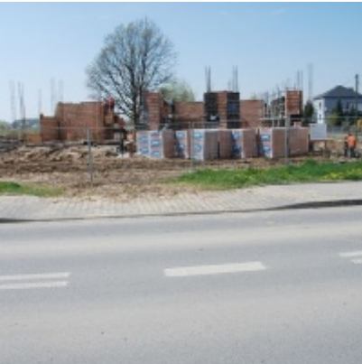
Budowa "Centrum Aktywizacji Zawodowej"
