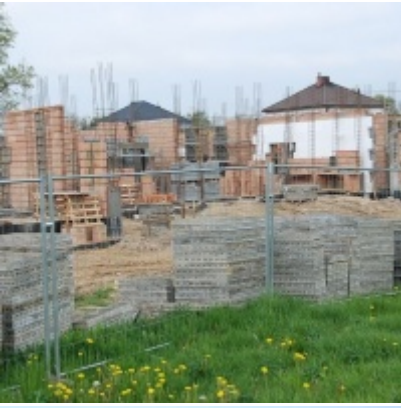
Budowa "Centrum Aktywizacji Zawodowej"
