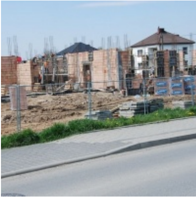
Budowa "Centrum Aktywizacji Zawodowej"
