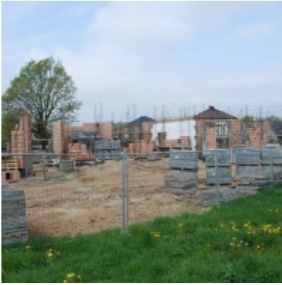
Budowa "Centrum Aktywizacji Zawodowej"
