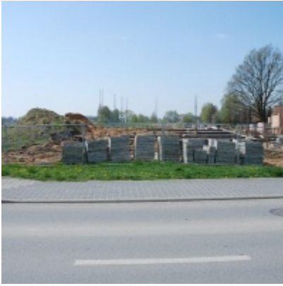
Budowa "Centrum Aktywizacji Zawodowej"
