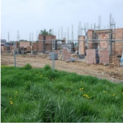
Budowa "Centrum Aktywizacji Zawodowej"
