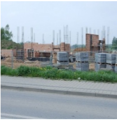
Budowa "Centrum Aktywizacji Zawodowej"
