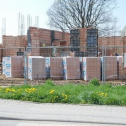
Budowa "Centrum Aktywizacji Zawodowej"
