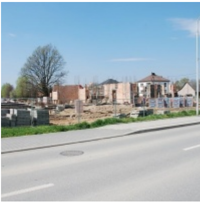
Budowa "Centrum Aktywizacji Zawodowej"
