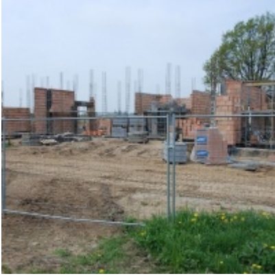
Budowa "Centrum Aktywizacji Zawodowej"
