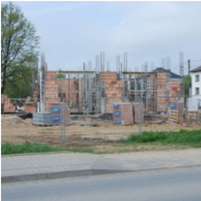
Budowa "Centrum Aktywizacji Zawodowej"
