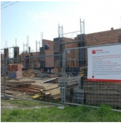
Budowa "Centrum Aktywizacji Zawodowej"
