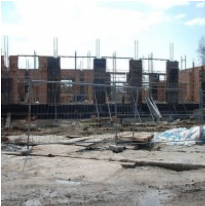
Budowa "Centrum Aktywizacji Zawodowej"
