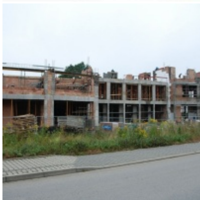
Budowa "Centrum Aktywizacji Zawodowej"
