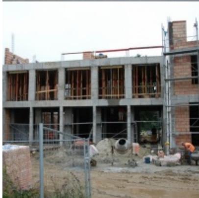
Budowa "Centrum Aktywizacji Zawodowej"
