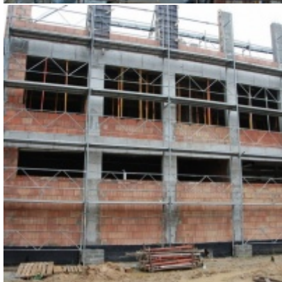
Budowa "Centrum Aktywizacji Zawodowej"
