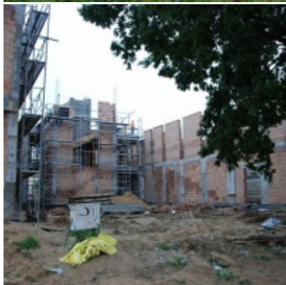
Budowa "Centrum Aktywizacji Zawodowej"
