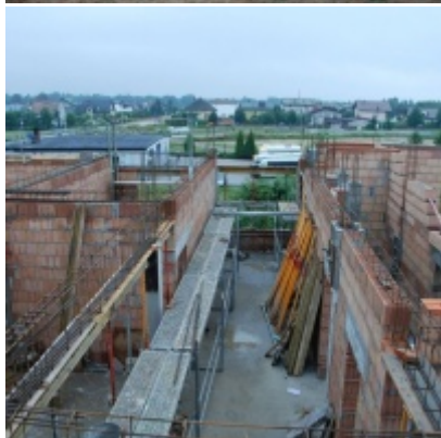
Budowa "Centrum Aktywizacji Zawodowej"
