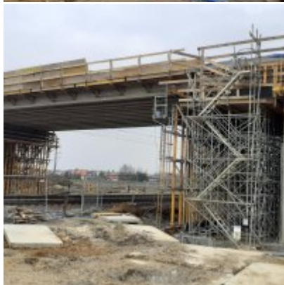
Postęp prac na budowie obwodnicy Podolsza DW 781
