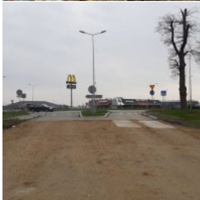
Postęp prac na budowie obwodnicy Podolsza DW 781
