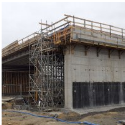
Postęp prac na budowie obwodnicy Podolsza DW 781
