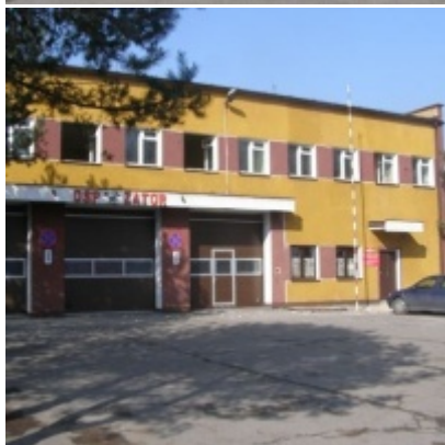
Przebudowa i modernizacja remizy strażackiej w Zatorze
