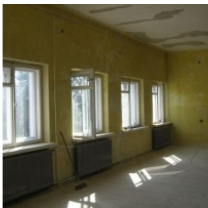
Przebudowa i modernizacja remizy strażackiej w Zatorze
