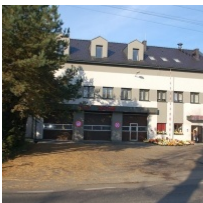
Modernizacja OSP w Zatorze
