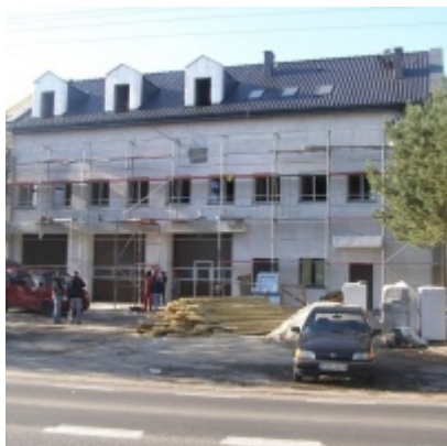
Modernizacja OSP w Zatorze
