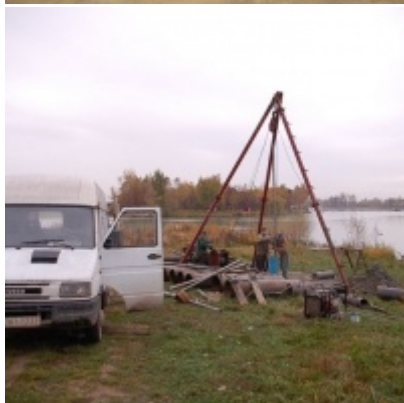
Nowe ujęcie wody pitnej
