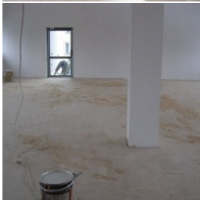
Modernizacja OSP w Zatorze
