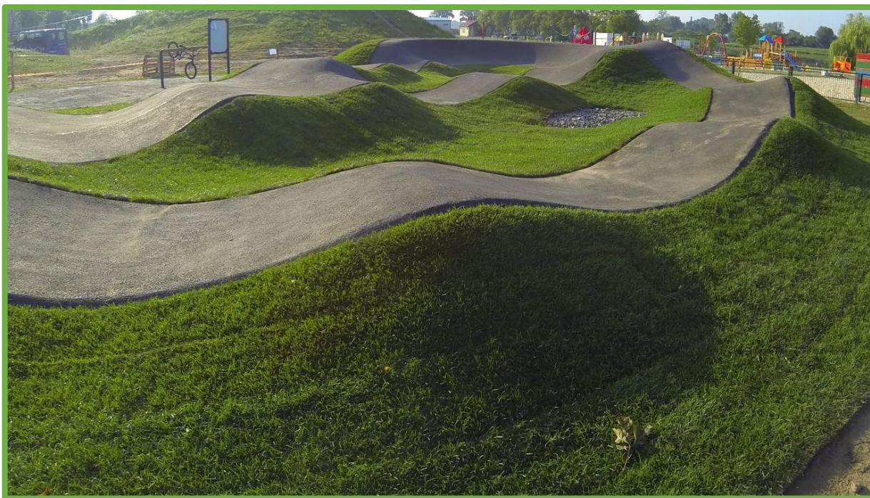
Garby o prawidłowo wyprofilowanych kształtach
