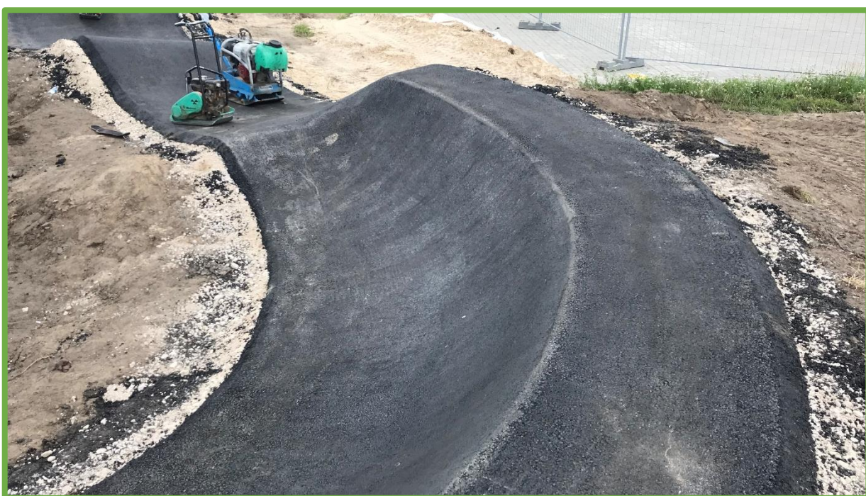
Prawidłowo wykonana nawierzchnia asfaltowa – jednorodna i gładka.
