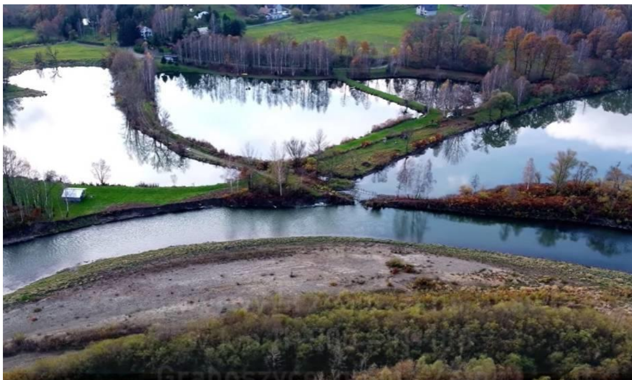
Graboszyce - lewy brzeg Skawy przed pracami naprawczymi.
