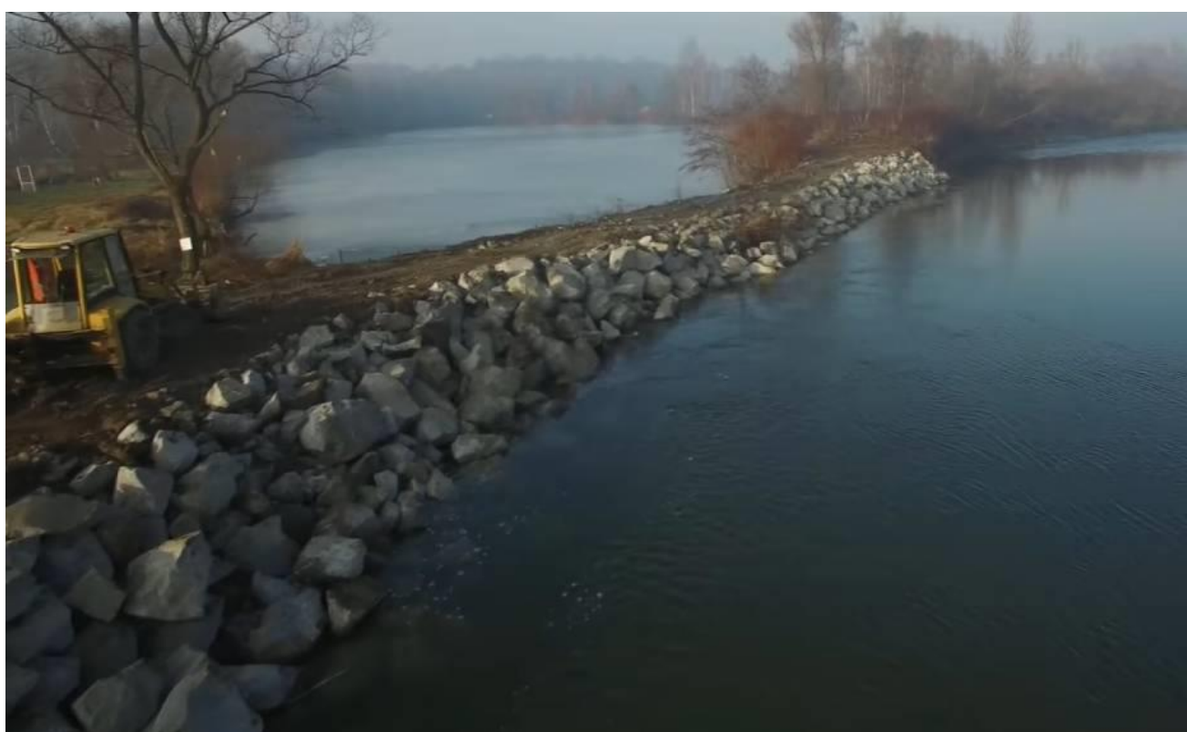
Graboszyce - lewy brzeg Skawy po przeprowadzeniu prac
